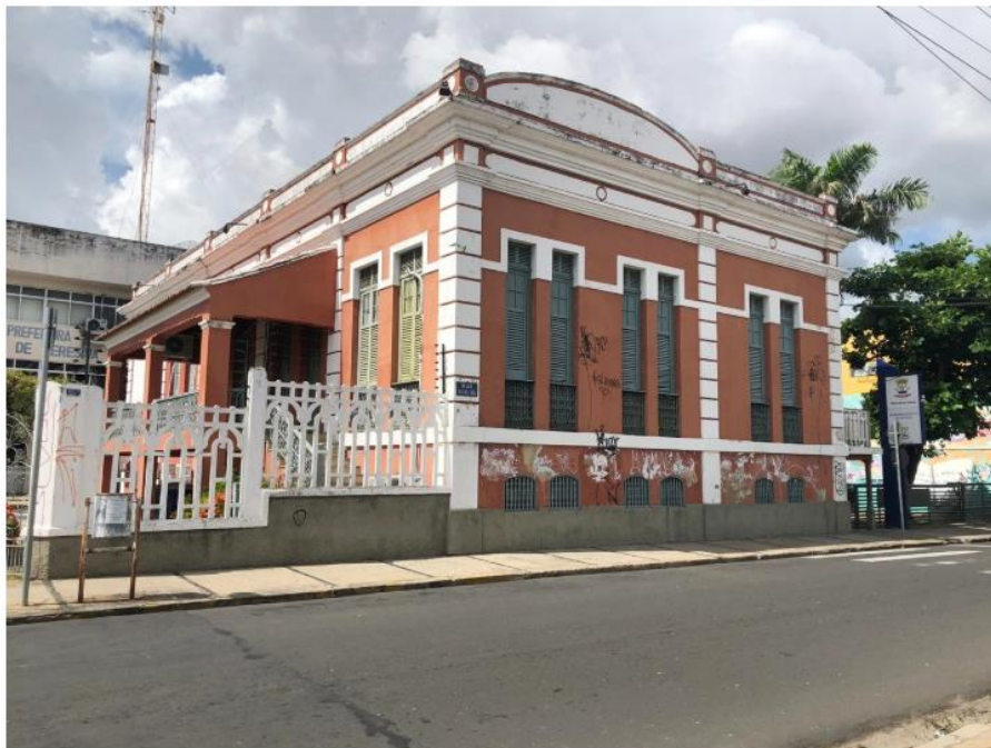
Prédio da Semec
